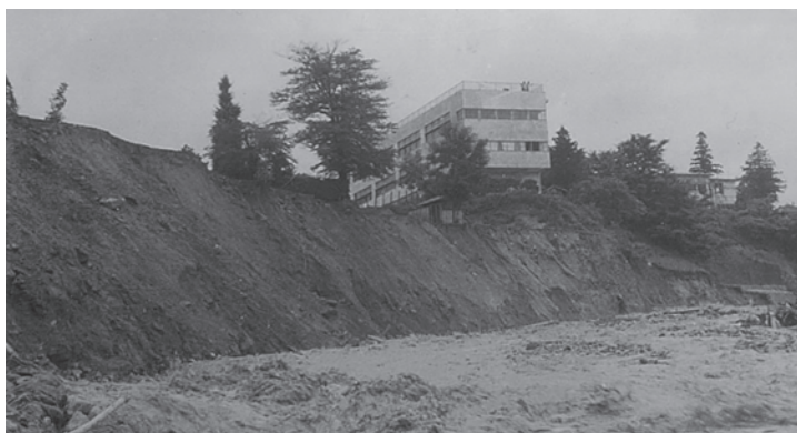
濁流に校庭の一部を削られた浜井場小学校
