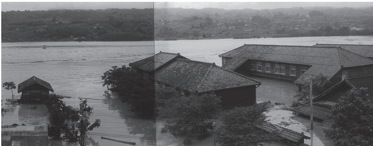
天竜川が氾濫し、校舎2階の窓まで浸水した川路小学校
