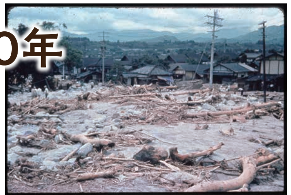
▲野底川の土石流で埋まった東中央通り
